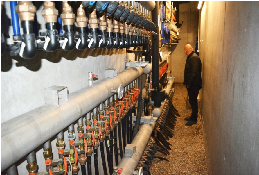
Abbildung 2: Aufwendiger Rohrleitungsbau für den Vor- und Rücklauf der 120 Energiepfähle beim ZMBP an der Universität Tübingen
