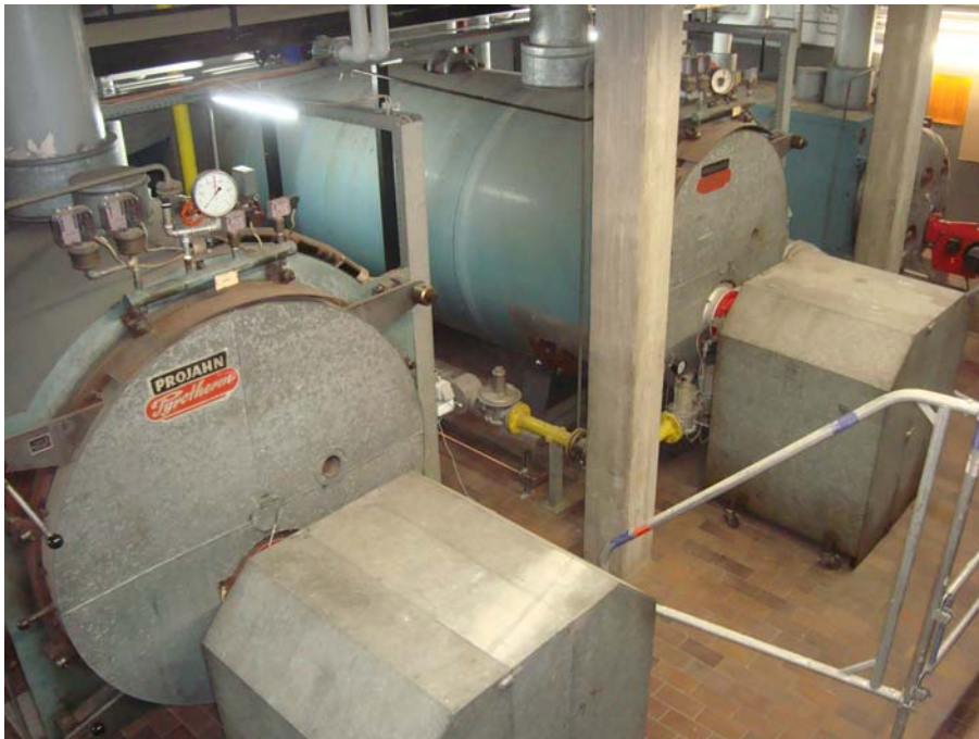
Abbildung 2: Dampfkessel der Staatlichen Akademie der bildenden Künste Stuttgart von 1965
